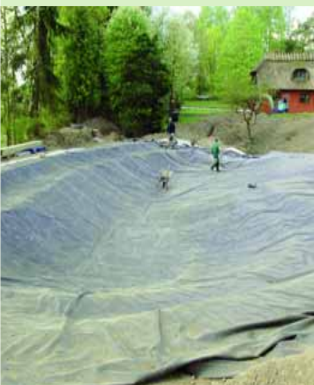
6. Dugen er her udlagt i et stort stykke i bassinet, hvorefter det 15 meter lange vandløb er sammenføjet. Vandløbet anes i det fjerne.
