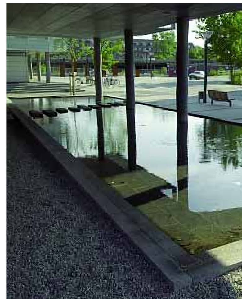
Gummidugen er her ført rundt om pillerne og placeret imellem de to rækker bordursten i bassinkanten.
