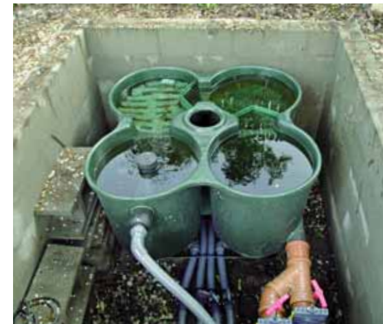
Filterstation med eksternt tilløbsfilter. Bemærk de fire udløb til faskinen.
