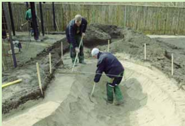
5. Gruset komprimeres og nivelleres meget omhyggeligt.
