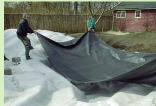
7. Gummidugen ilægges af flere mand, så geotekstilet ikke forskubber sig.
