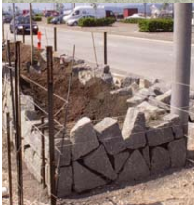
Mur i setzsteine under opbygning
