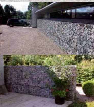
Stenkister (gabioner) fyldt med brudsten
