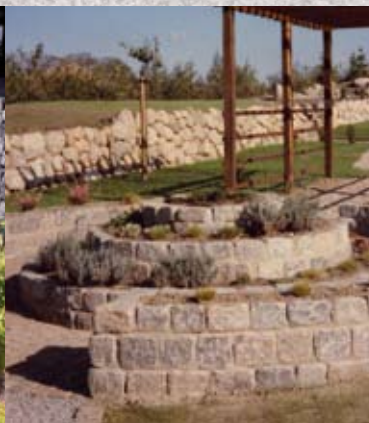
Brostensmur i halvforbandt i slidte nordiske brosten sat i beton
